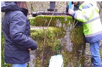
Visite de contrôle d'un captage d'eau potable
