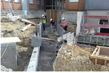
Travaux des collèges
