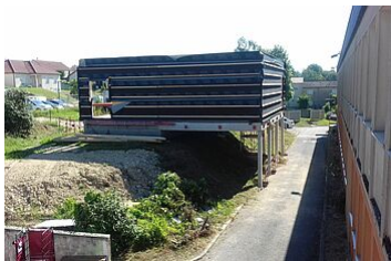
Travaux des collèges d'Ancemont
