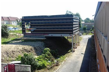
Travaux des collèges d'Ancemont
