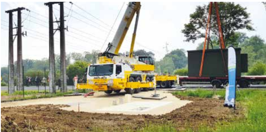
Installation du nœud de raccordement optique à Saudrupt.
