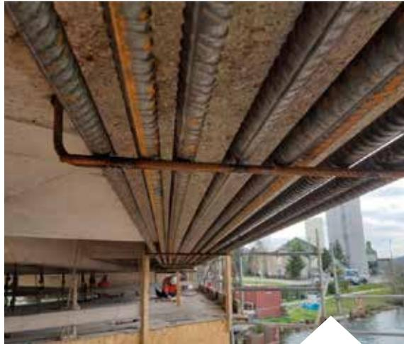
La construction de talons additionnels pour renforcer les poutres au-dessus du canal.
