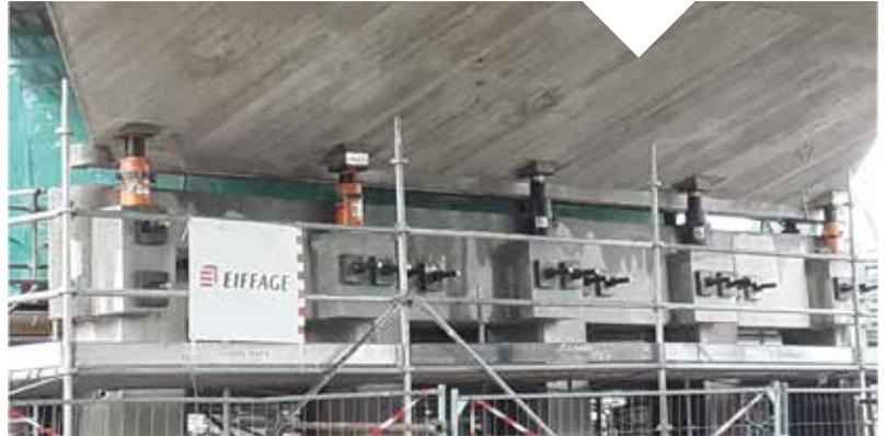
L'hydrodémolition du tablier au niveau des joints cantilever par jet d'eau à ultra haute pression.
